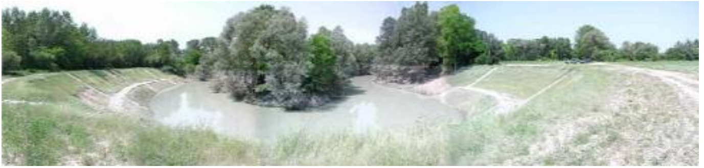
Impianto di consolidamento realizzato con i PRATI ARMATI ® per il Genio Civile in Friuli sull'ansa di un fiume; l'impianto ha retto all'alluvione del maggio 2002 con un battente d'acqua di quasi 20 metri e portate di 1.400 mc/sec.
