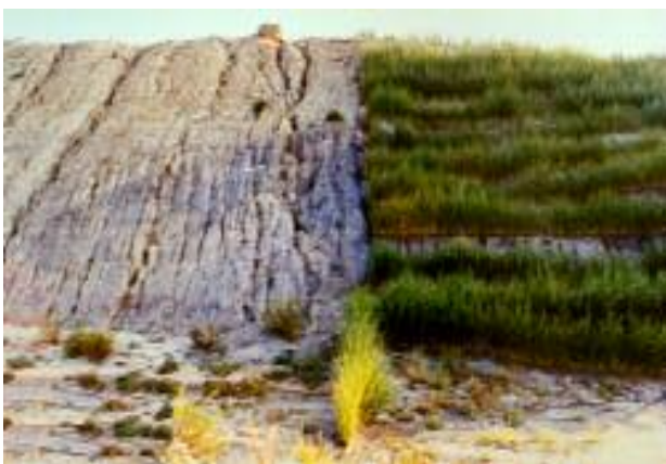
Zona ad alta pendenza consolidata con i PRATI ARMATI ®: si noti l'erosione nella parte non consolidata.
